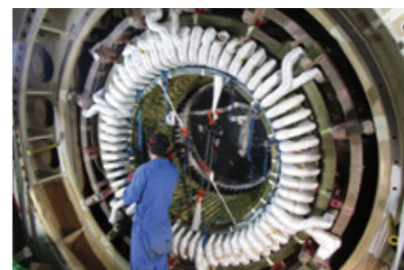
発電所発電機の巻替え実績
