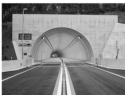
写真5 トンネル・道路照明工事新設、LED 灯への改修
