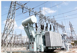
電力会社の変電所
